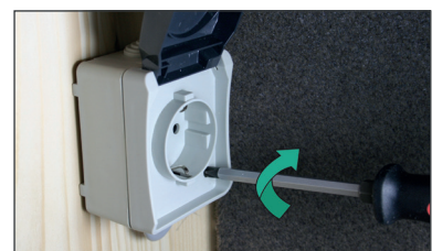
3. Steckdosen-Gehäuse aufsetzen und Schrauben anziehen
