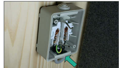
2. Graue Führung in das Gehäuse schieben und Steckdose einsetzen
